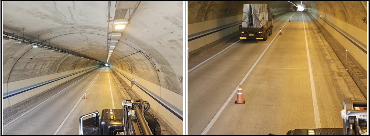
【사진 4.3.25】 포장부 전경
