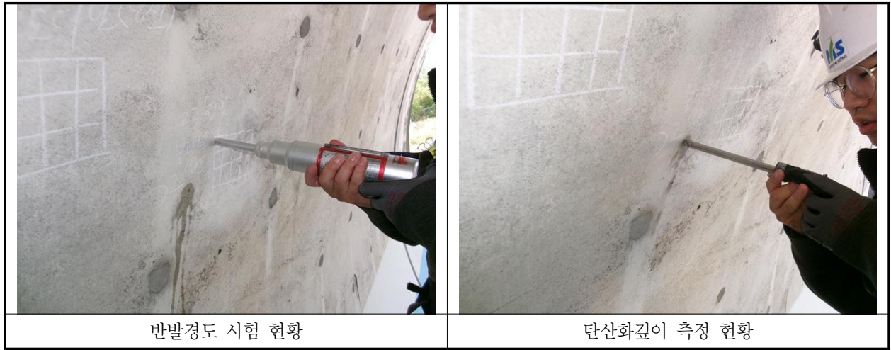
【사진 4.4.1】 콘크리트 내구성조사 현황
