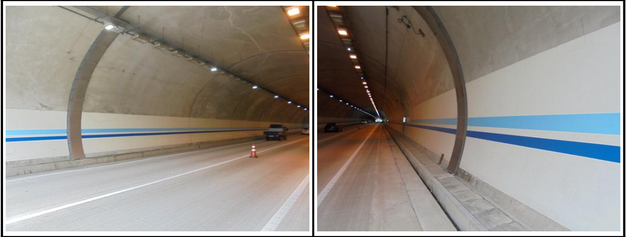
【사진 4.3.3】 라이닝 측벽부 전경
