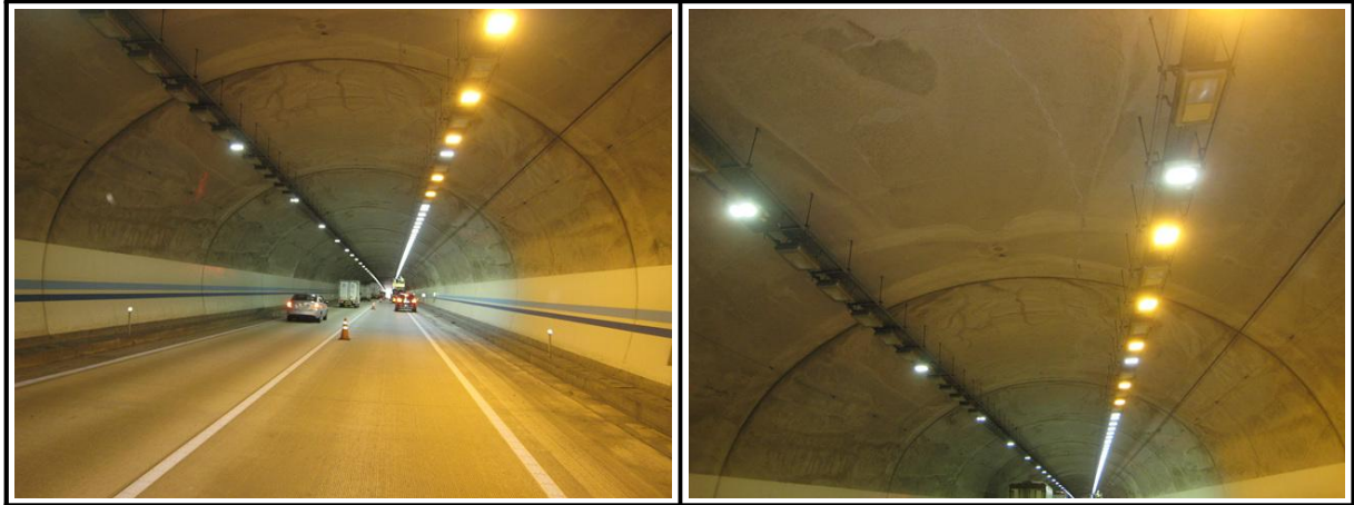
【사진 4.3.15】 라이닝 천단부 전경
