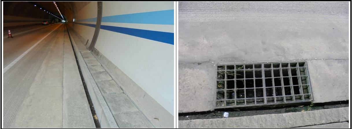
【사진 4.3.9】 공동구 및 배수시설 전경
