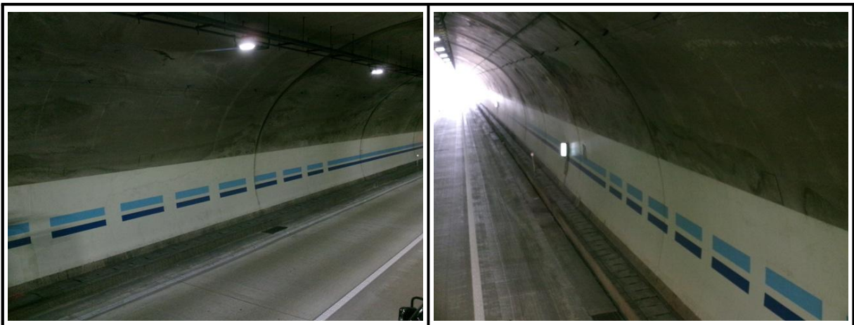
【사진 4.3.17】 라이닝 측벽부 전경
