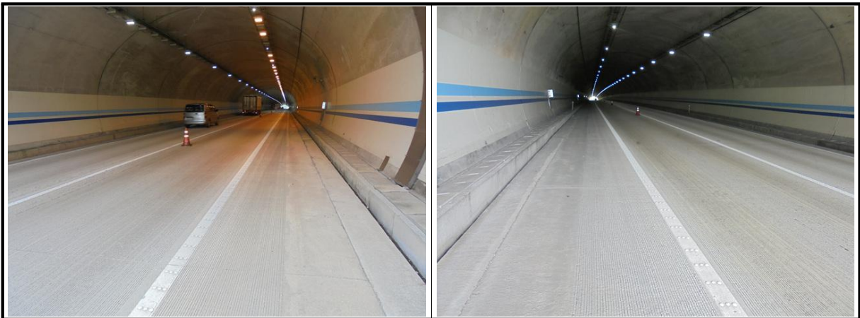
【사진 4.3.11】 포장부 전경
